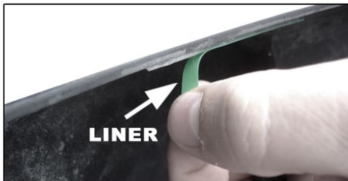
D) Desgrudar uma ponta (liner) da fita adesiva para facilitar sua retirada posteriormente.
